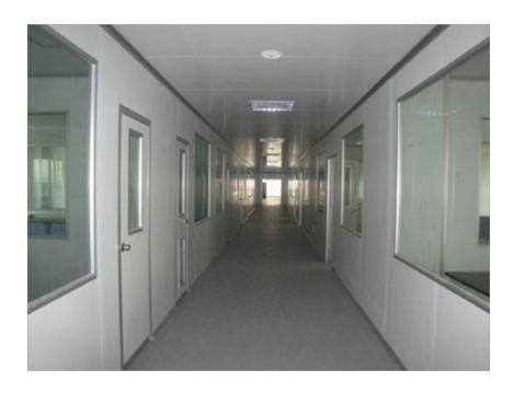
净化车间室内装修:净化车间的建筑围护结构和室内装修,应选用气密性良好,且在温度和湿度等变化作用下变形小的材料。墙面内装修当需附加构造骨架和保温层时。应采用非燃烧体或难燃烧体。净化车间内墙壁和顶棚的表面,应符合平整、光滑、不起灰、避免眩光、便于除尘等要求。应减少凹凸面,阴阳角做成圆角。室内装修宜采用于操作。如为抹灰时,应采用高级抹灰标准。净化车间的地面,应符合平整、耐磨、易除尘清洗、不易积聚静电、避免眩光、并有舒适感等要求。
